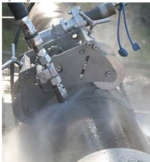
Rys. 9. Końcówka służąca do cięcia i chłodzenia butli lub rur
